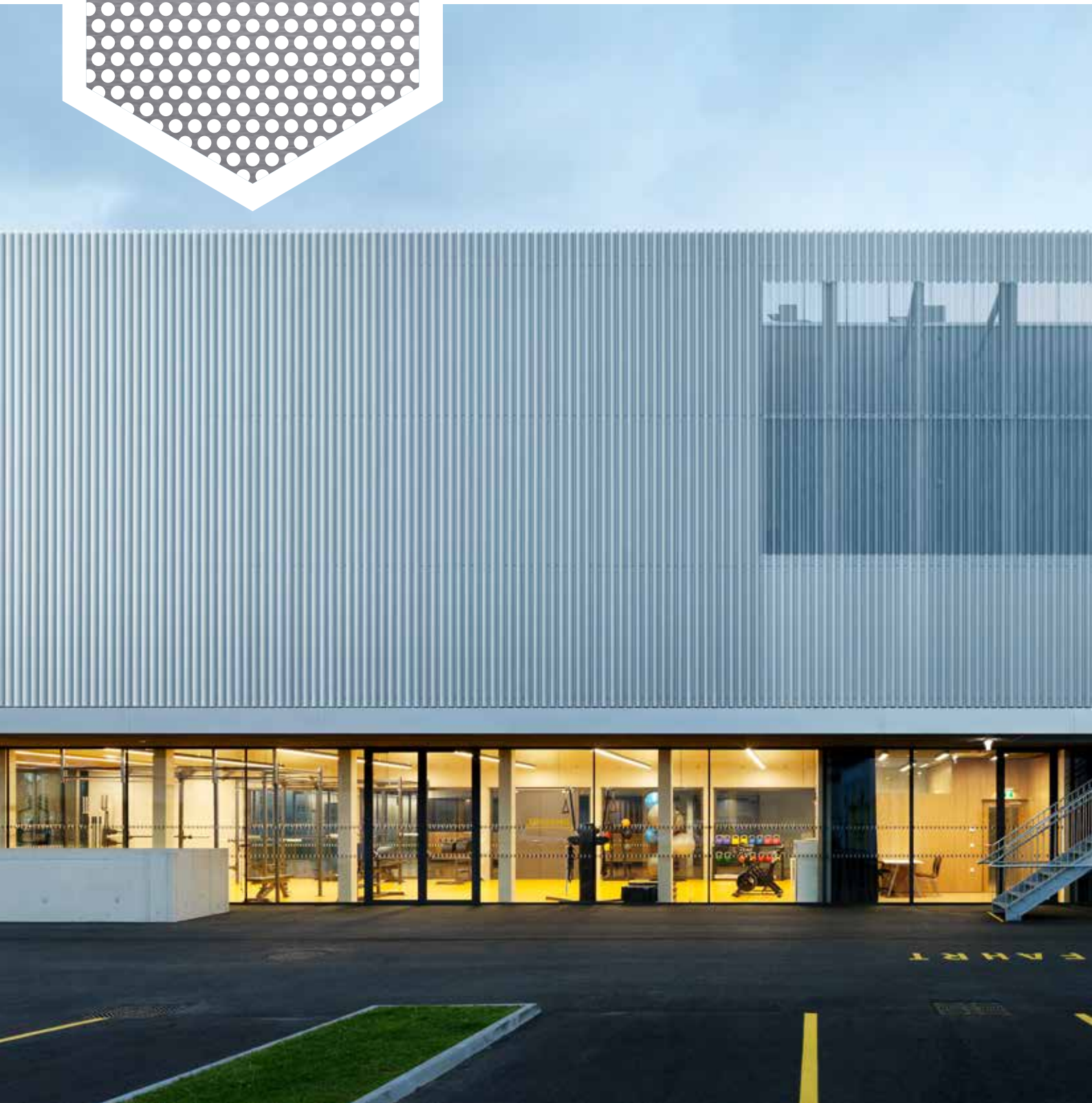
Raiffeisen Sportpark, Graz: prismenförmiges Architekturprofil aus ROOFINOX CLASSIC mit gelochten Teilbereichen
